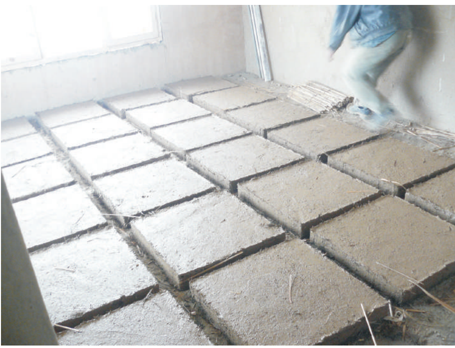
Fabrication, utilisation et mise en oeuvre de placo-terre (60x60x8cmm)
