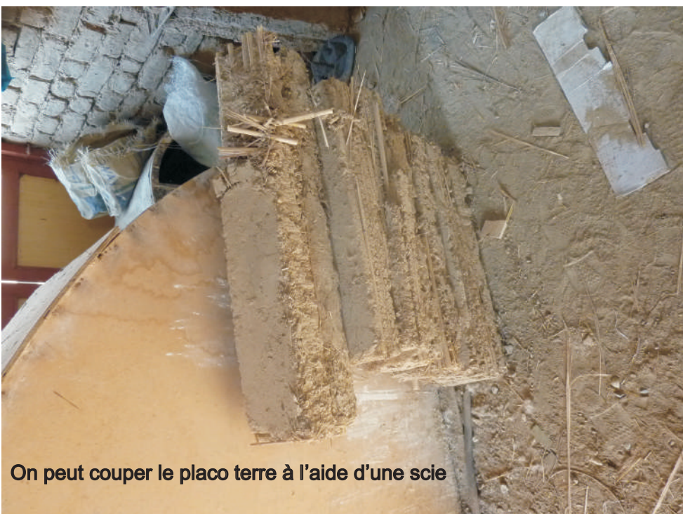
Mur en placo-terre, panneaux (100x60x8cm)
