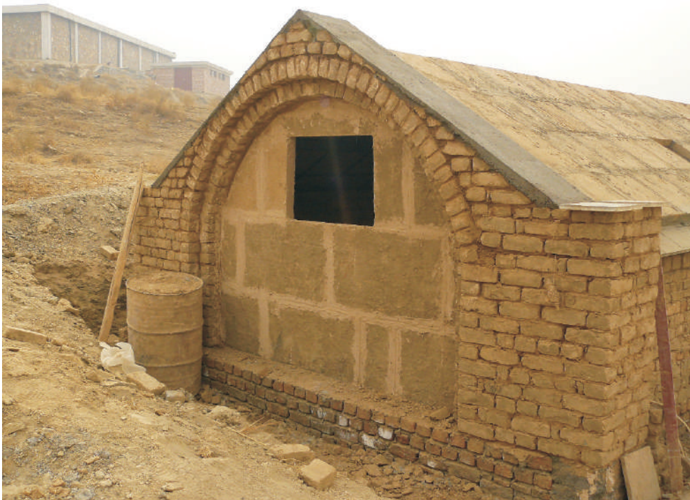
Mur en placo-terre, panneaux (100x60x8cm)
