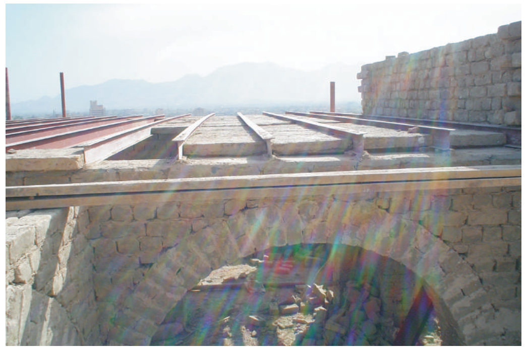
Fabrication, utilisation et mise en oeuvre de placo-terre (60x60x8cmm)
